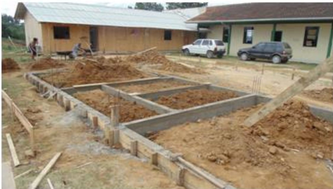
Fig: 8- E.I.E.B "Vanhecú Patté" com início da reforma para o novo prédio: Fotos: Simeão K Priprá. 2014
